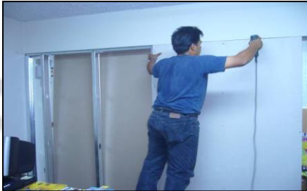
TABIQUE GYPLAC- OFICINAS PARA PAGINAS AMARILLAS.
