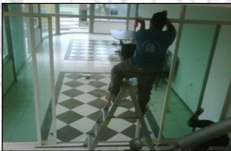
Instalación de Ventanas de Aluminio Local Zarate
