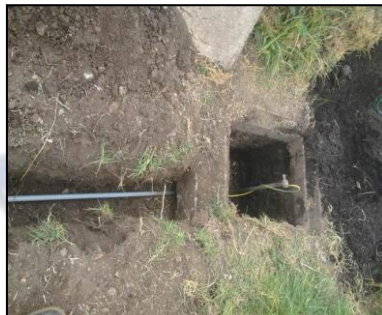
. Instalación tablero eléctrico en cliente BMP.
