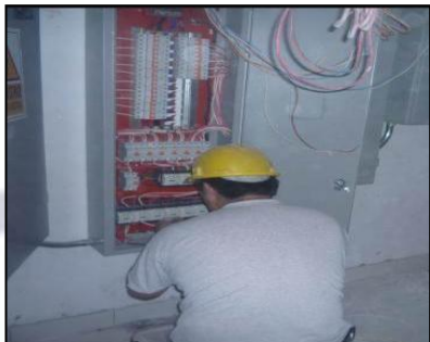
. Instalación sistema PAT en CIP Huancayo.
