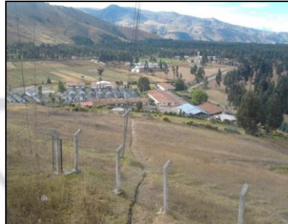
. Instalación canalizada para cableado de datos en CIP Huancayo.
